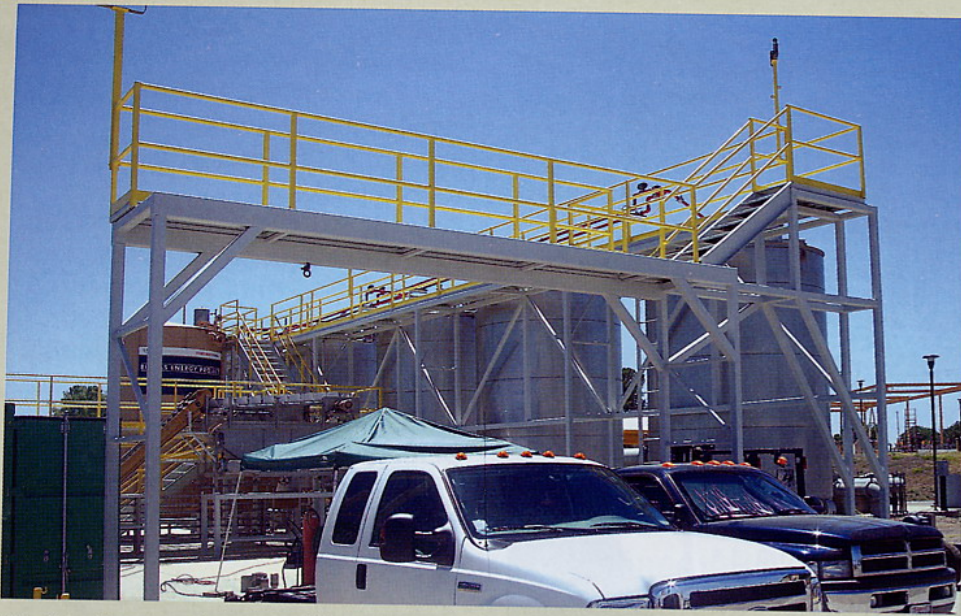
Oksijensiz ortamda yaşayabilen bakterilerden yararlanmaya dayanan sistem, organik atıkların gaz haline dönüştürülmesini sağlıyor. Gaz enerji üretiminde kullanılıyor.
