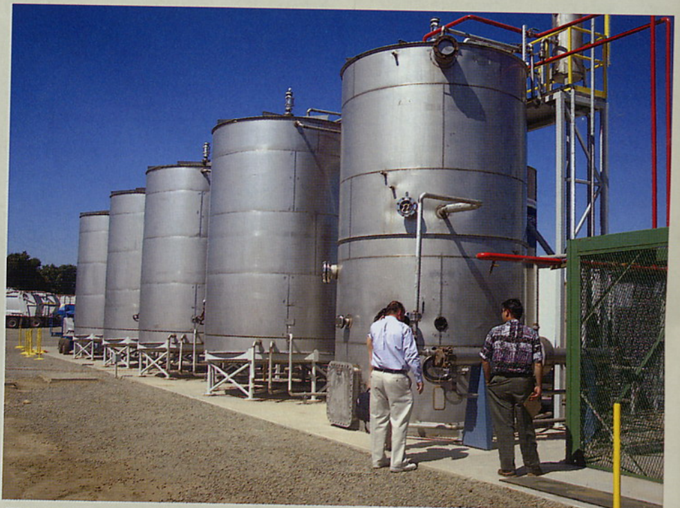
Elde edilen gaz sıkıştırılmış veya sıvılaştırılmış halde tanklarda depolanıyor. Bundan sonra gaz ister doğrudan, istenirse elektrik üretimi için kullanılabilir.
